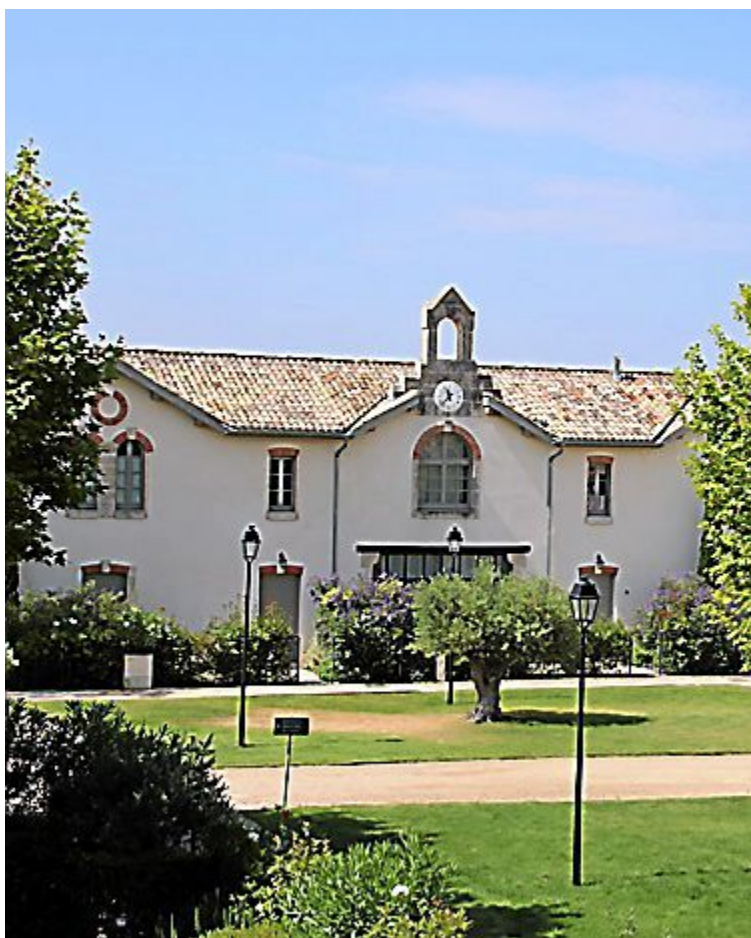
La maison des vendangeurs accueille actuellement des résidences de luxe, certaines avec piscine privée. - MIDI LIBRE
